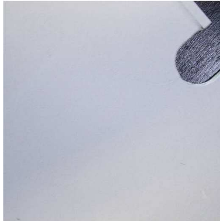
offener Riss - lackiert
